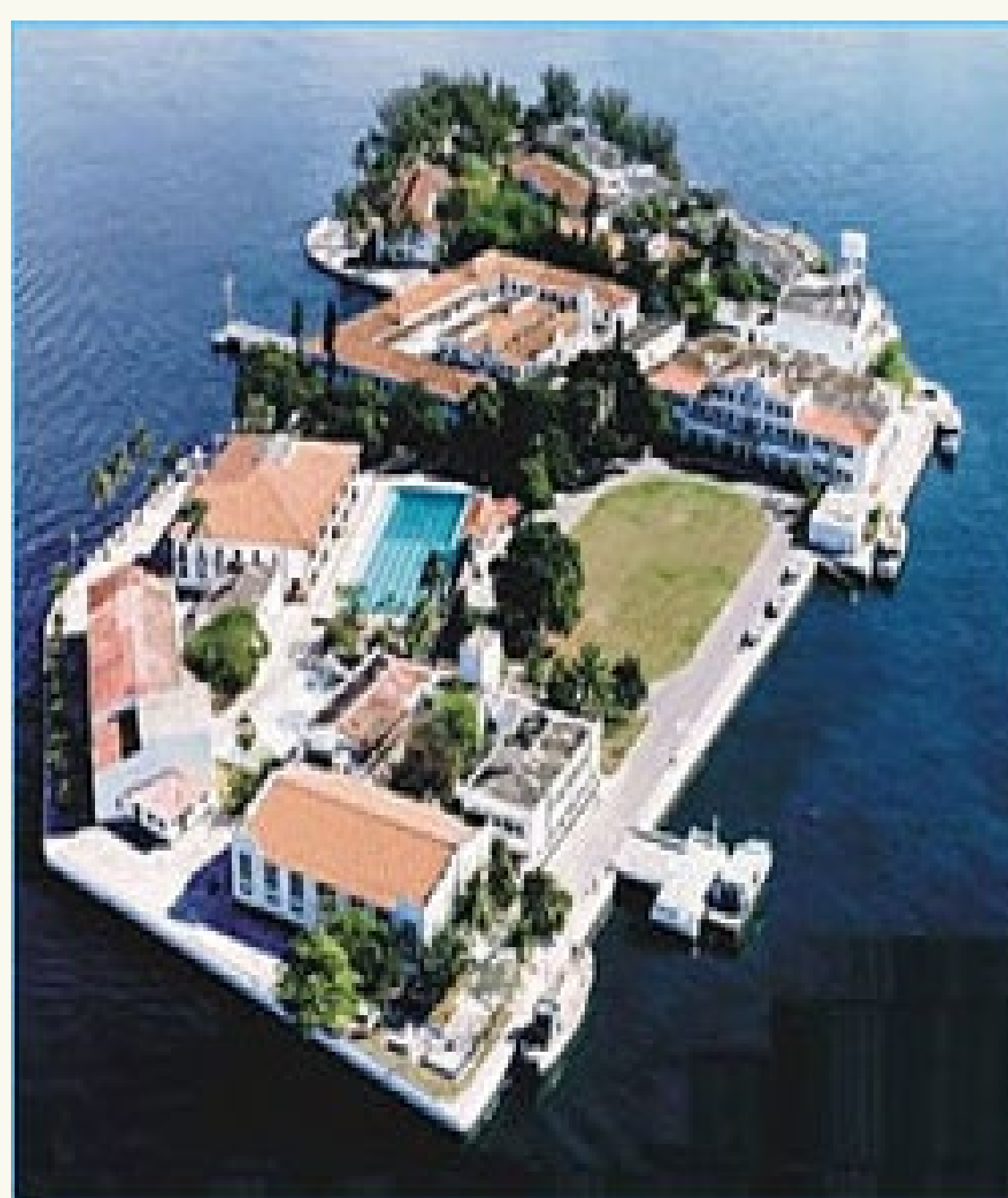
Fig. 3 Instalações do Centro de Esportes da Marinha-CEM em ilha da Baía de Guanabara, Rio de Janeiro, em foto de 1960, na qual se identificam a piscina olímpica e a pista de atletismo num único conjunto.
