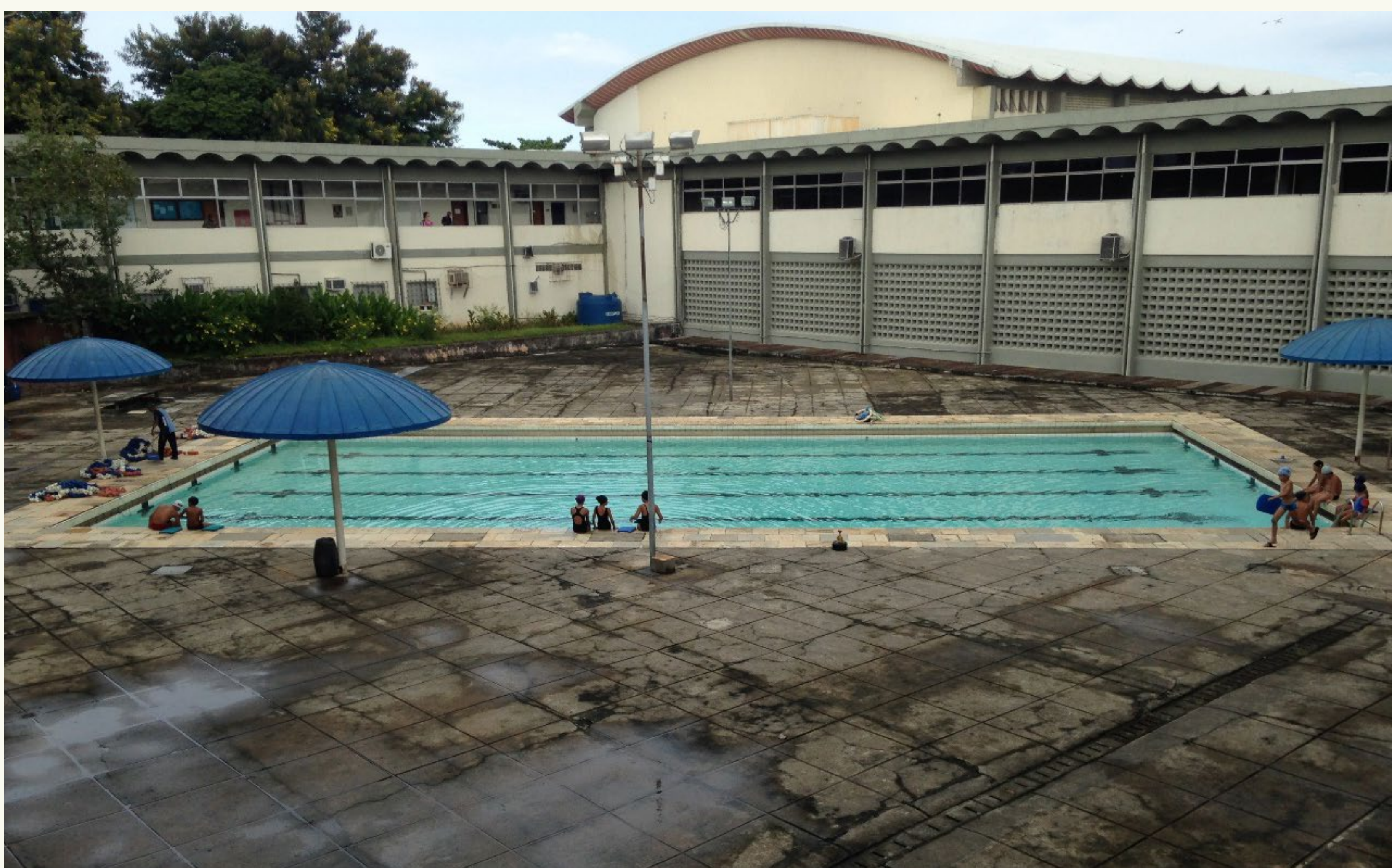
Figura 13 - Piscina da Escola de Educação Física da UFRJ, foto tirada em 20/03/2017.
