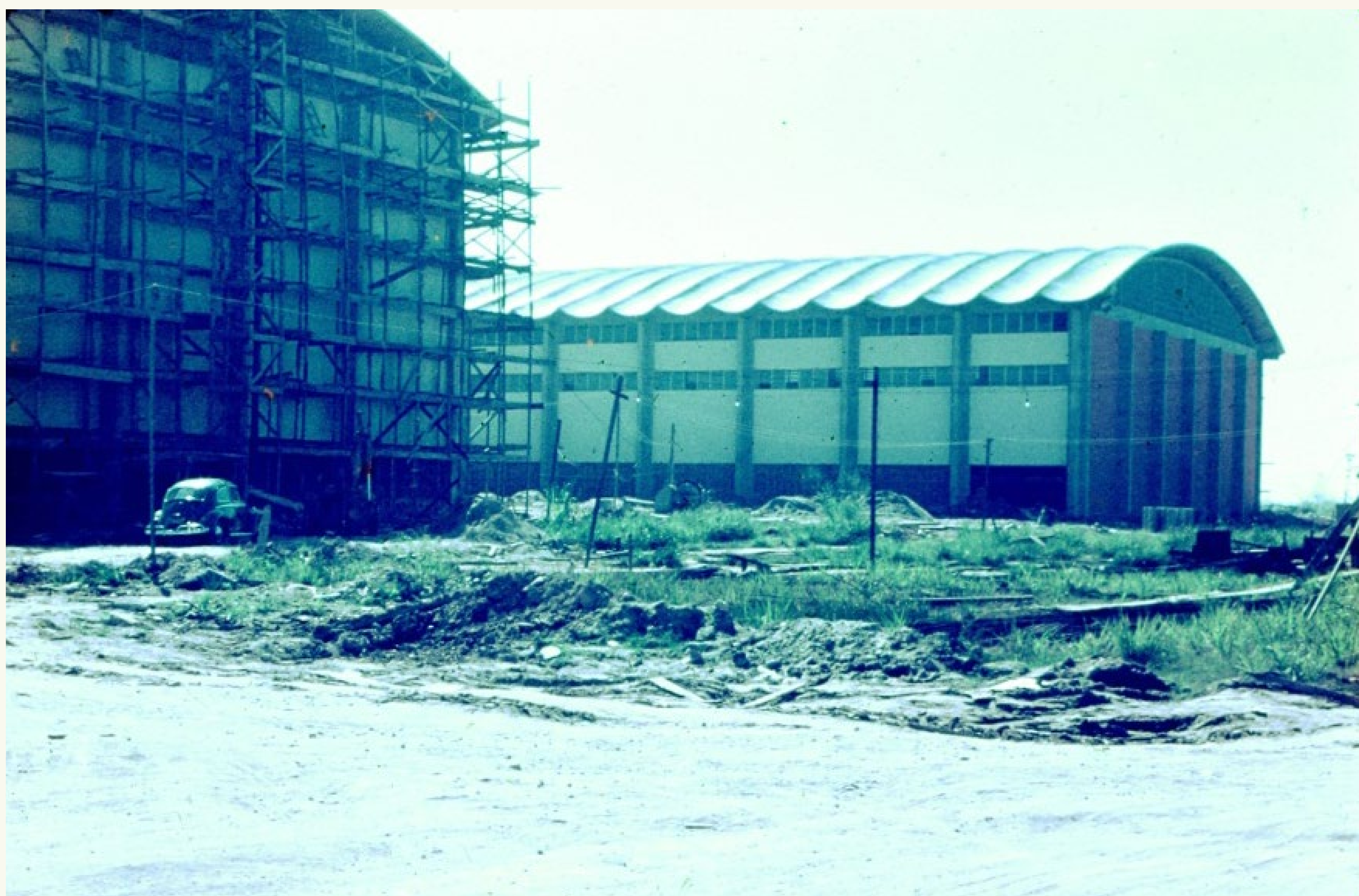
Obras de construção dos Ginásios na Ilha do Fundão. Foto de Paulo Murilo Iracema. Acervo: Alfredo Faria Junior.
