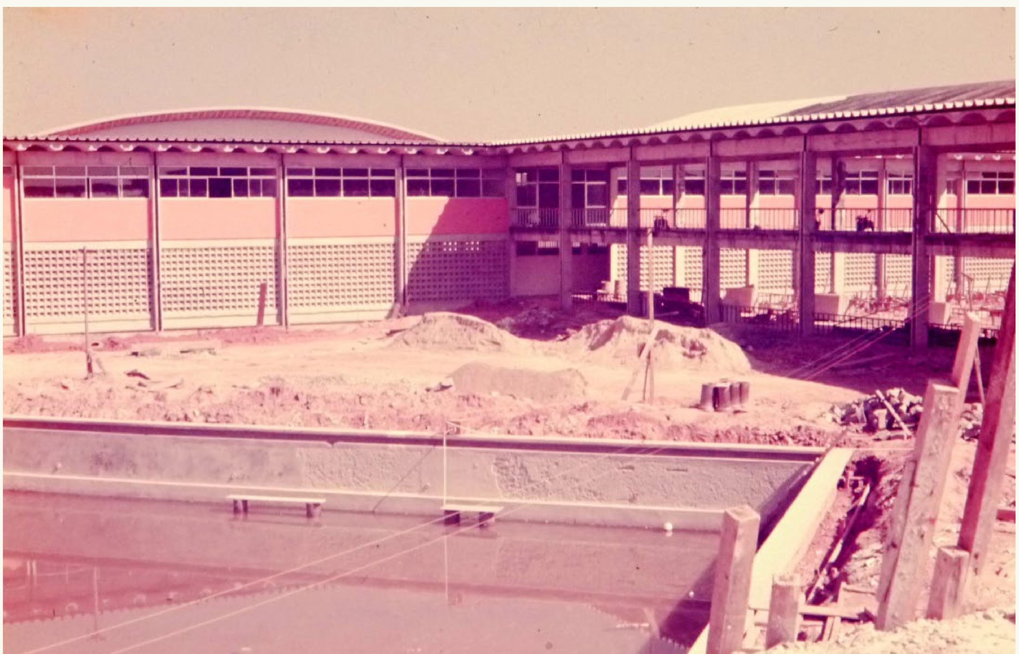
Construção das Piscinas da EEFD no novo campus do Fundão.
